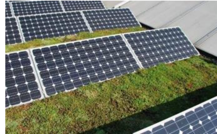
zonnepanelen op sedumdak
