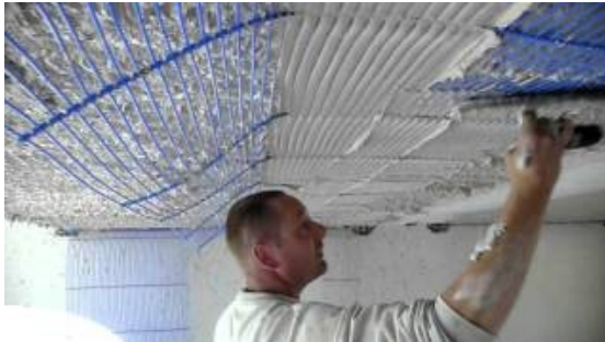
Lage temperatuur afgiftesysteem > Bijvoorbeeld in het plafond, d.m.v. capillaire buismatten; heel dun!
