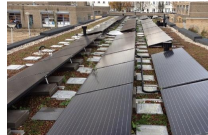
Extra bron in de vorm van: > Warmtecollectoren met PV geïntegreerd of gestapeld.
