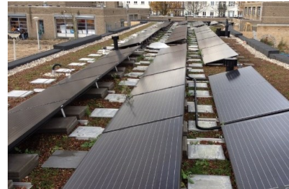
Extra bron in de vorm van: > Warmtecollectoren met PV geïntegreerd of gestapeld.
